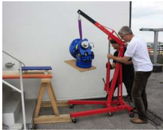
Die Teile der neuen Montierung werden mit raffinierter Technik und unter Einhaltung sämtlicher bekannter Sicherheitsvorschriften von den Fachmännern in die 5m-Kuppel bugsiert.
